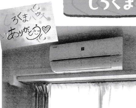
▲エアコン設置
